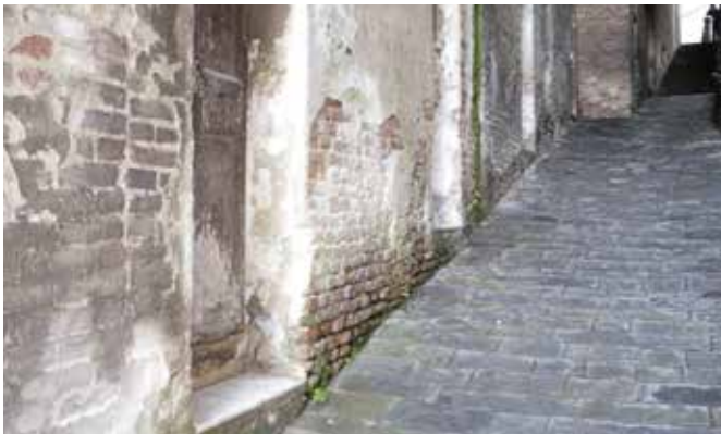
Vernietiging van de mortel- en mortelvoegen
