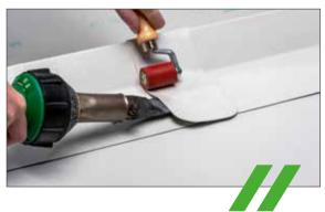
direkt an das Blech angeschlossen werden. Im Stoßbereich werden die Verbundbleche mit mindestens 10 cm breiten Streifen aus KÖSTER TPO U abgedichtet. Dieser ist umlaufend zu verschweißen
