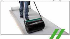
// Anschließend muss die Dachbahn vollflächig angedrückt werden. Dazu verwendet man idealerweise eine Andrückwalze.
