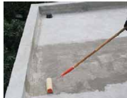
Grundierung mit KÖSTER Polysil® TG 500
